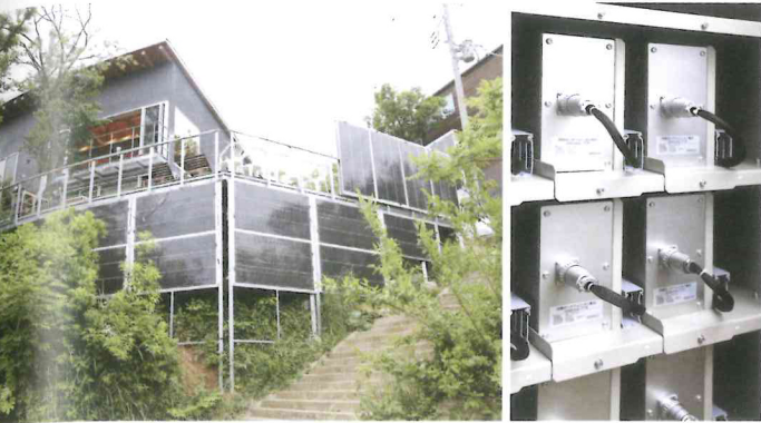
屋根上だけでなく壁面にもパネルが(左)。容量72kWhのリチウムイオン蓄電池(右)
